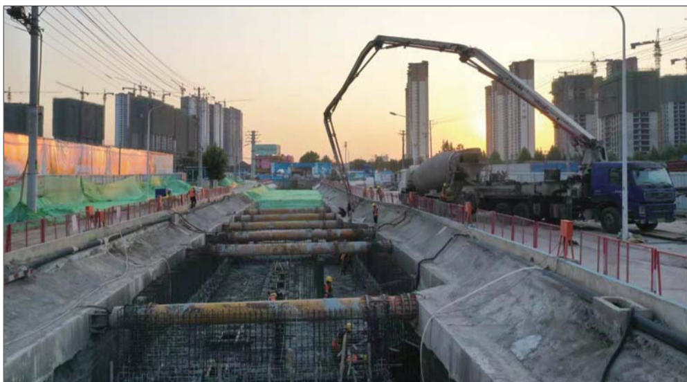
车站西路综合管廊工程施工现场。齐鲁晚报·齐鲁壹点记者 周惠娇 摄
