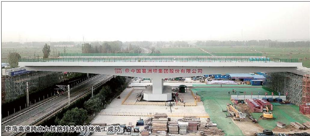
枣菏高速跨京九铁路转体桥转体施工成功。
