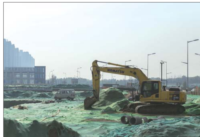
项目施工现场。
