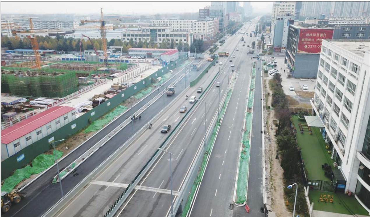
火炬路跨线桥全线贯通。
