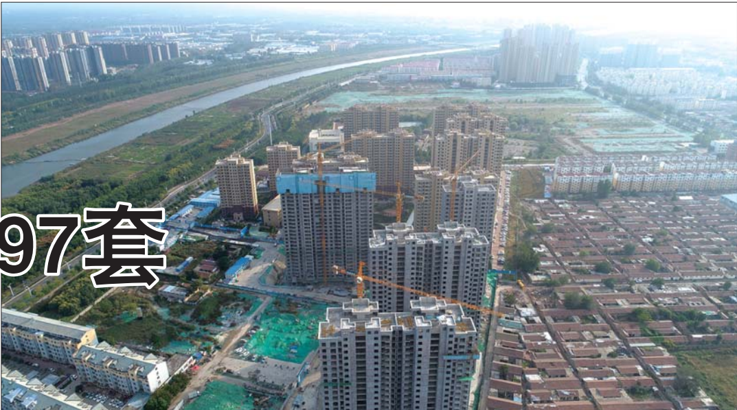
正在建设中的池口社区。
