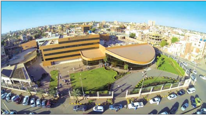
德建集团施工的苏丹国际皇家医院项目
