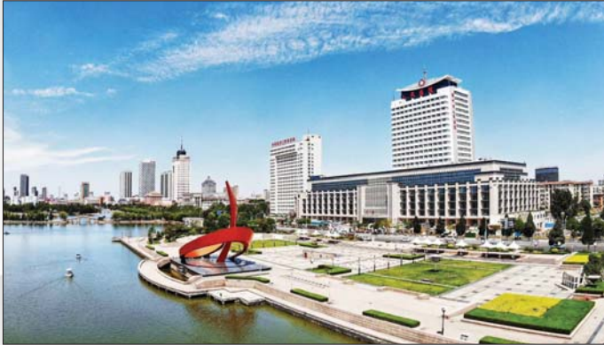
德建集团施工的德州市人民医院新病房楼项目
