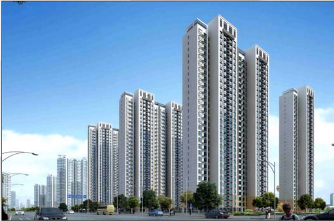
德建集团施工的河北保定长城家园项目
