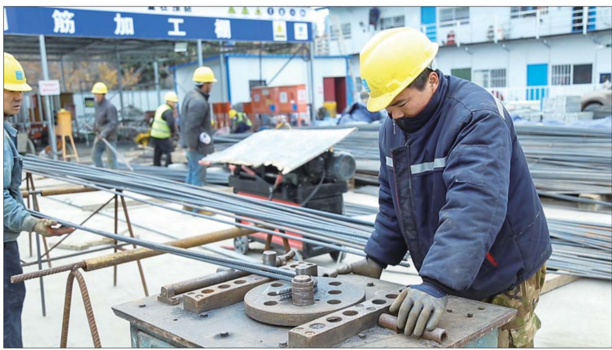
新运河8#泵站施工现场。
