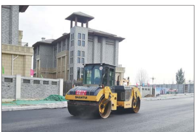
会通路道路工程沥青摊铺施工。
