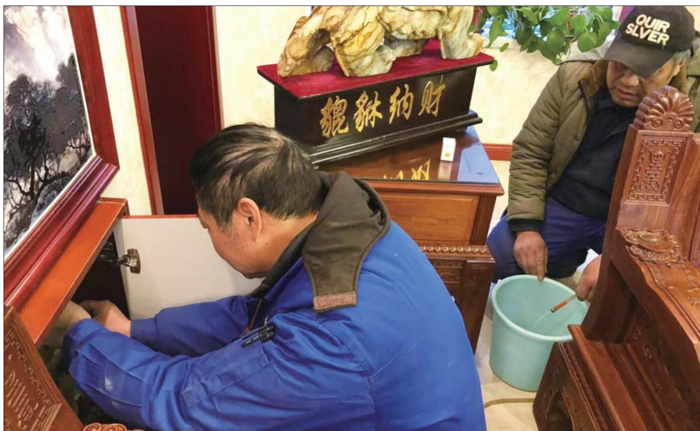
工作人员对分水器进行排气。齐鲁晚报·齐鲁壹点 记者 周惠娇 摄
