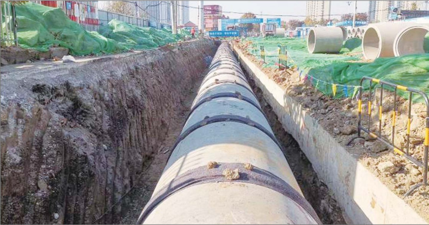
管廊工程已经接近尾声。
