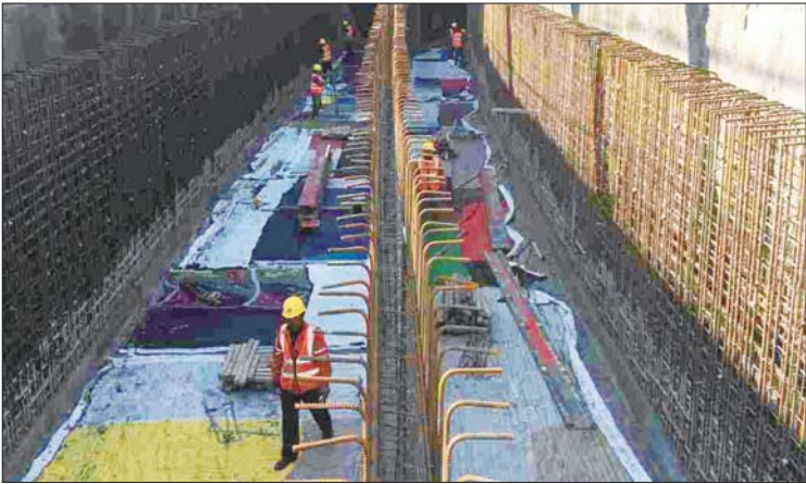
现场工人正在施工。
