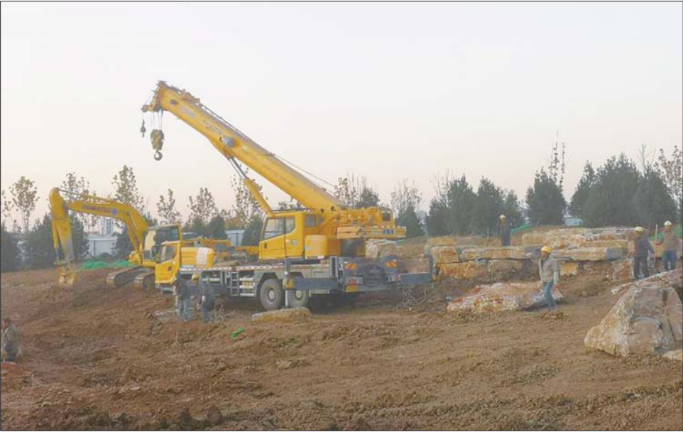
鸿广河项目施工现场，正在进行景石安装。
