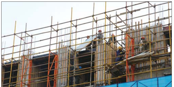
工人正在有序施工。
