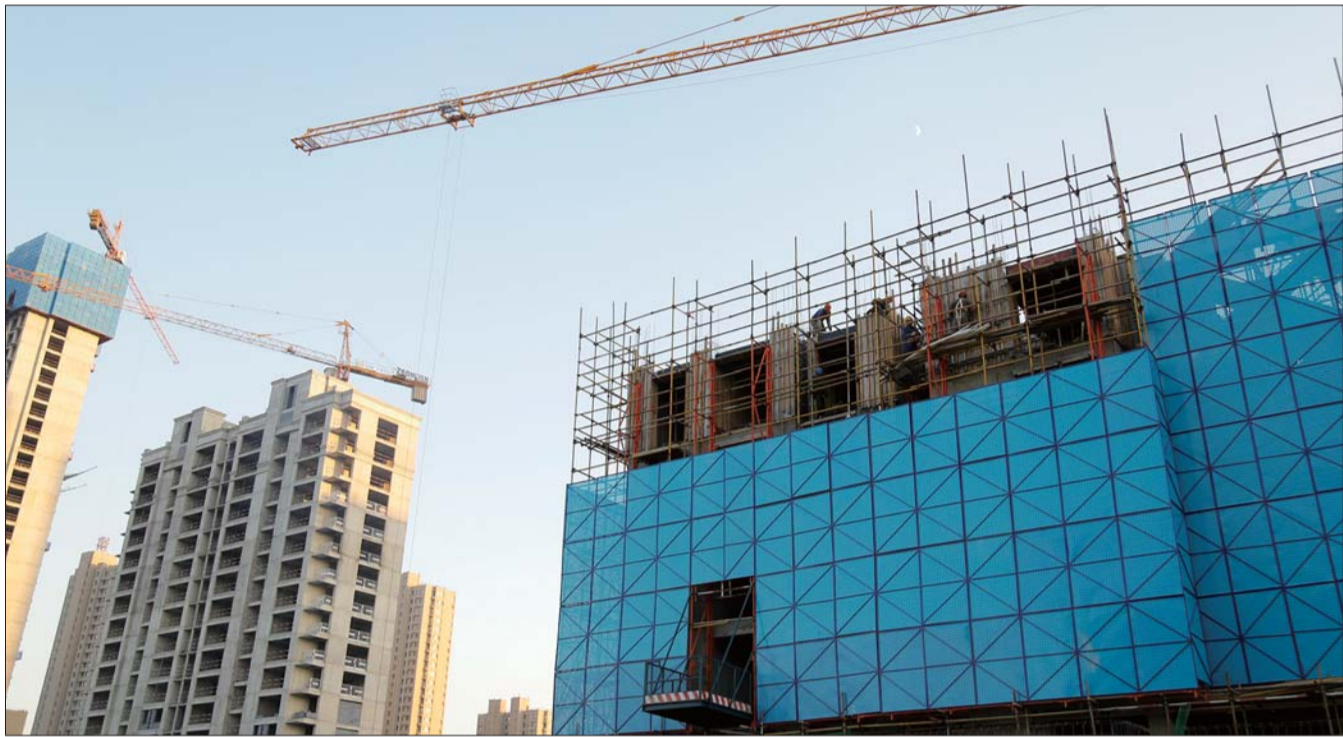
项目施工现场。
