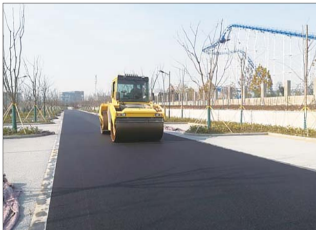
停车场内,正在铺设沥青路面。
