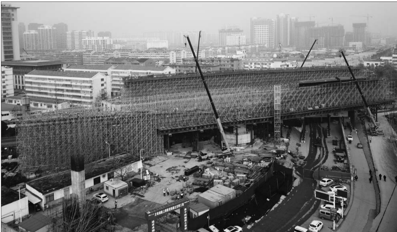
转体梁满堂支架已经搭设完成。
