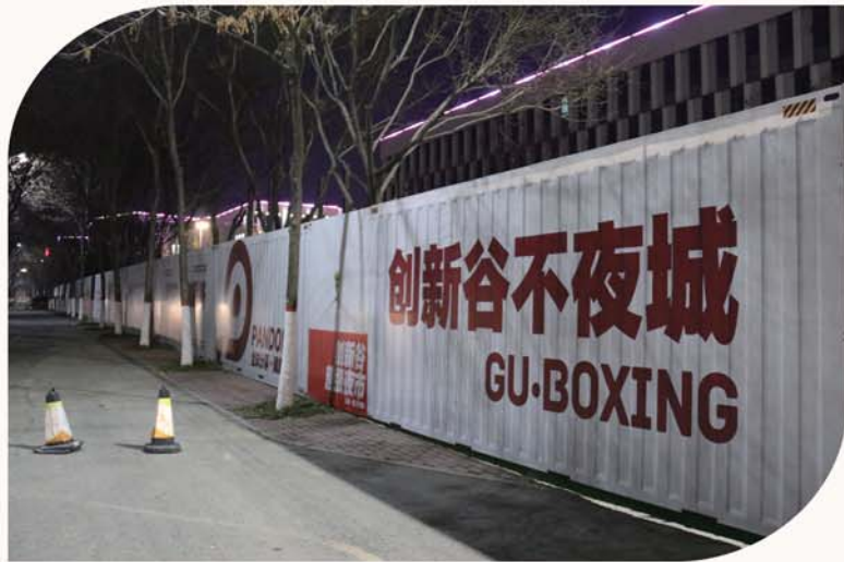
集装箱小镇正在建设中。
