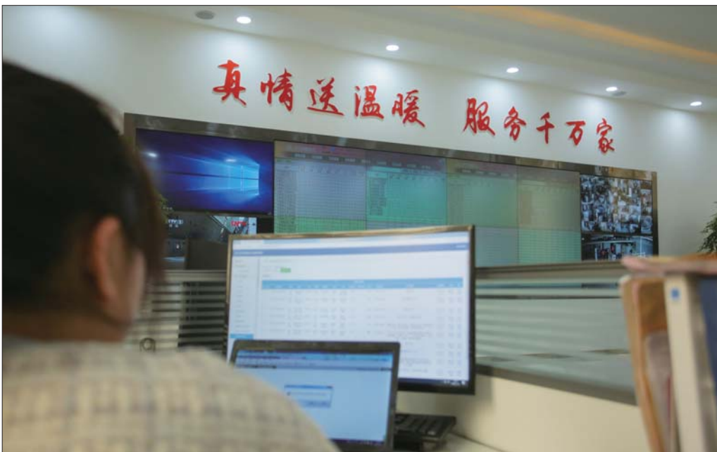
四和供热调度中心实时监控供暖数据。齐鲁晚报·齐鲁壹点见习记者 王浩然 摄
