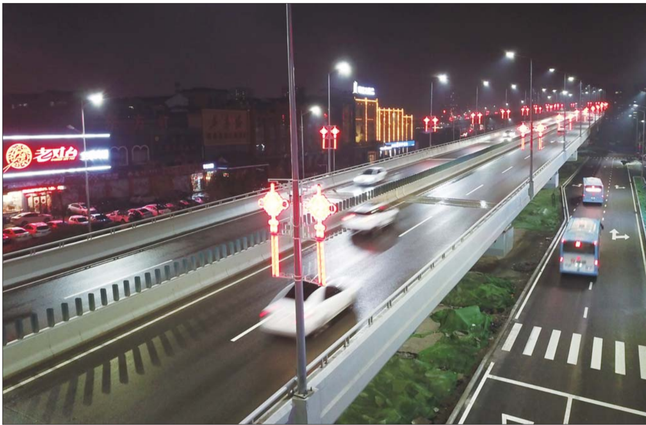
火炬路跨线桥桥面两侧安装了中国结造型的彩灯,年味儿十足。
