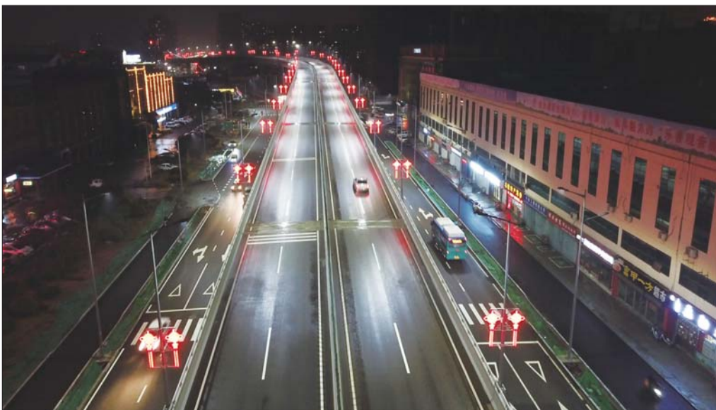
火炬路跨线桥换上了“新装”。
