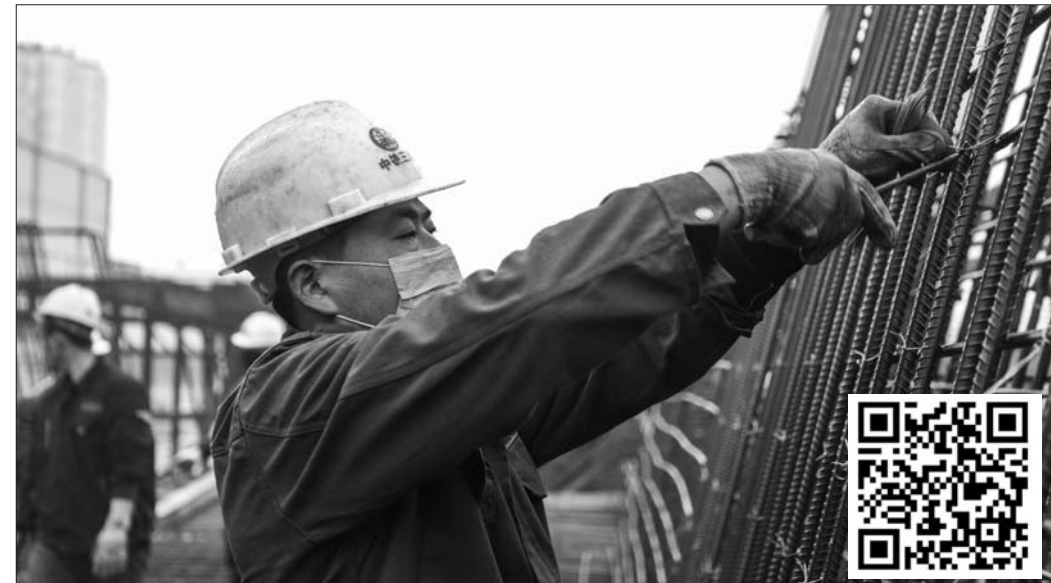
工人们带着口罩,动作娴熟地捆扎钢筋。
