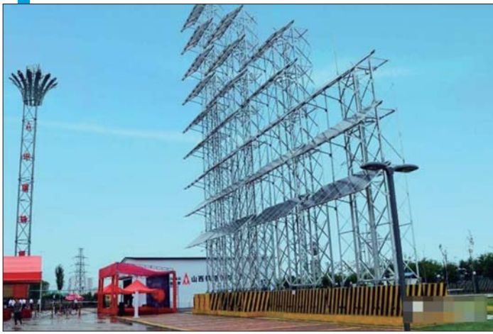
中国铁塔已完成数字化转型。
