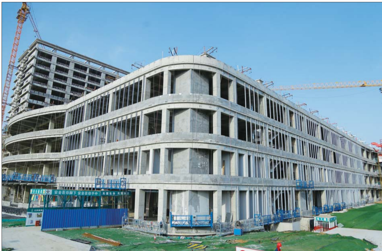
项目目前正在进行二次结构的维护工作。
