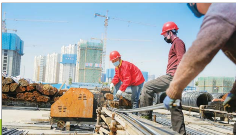
施工人员进行钢筋切割作业。
