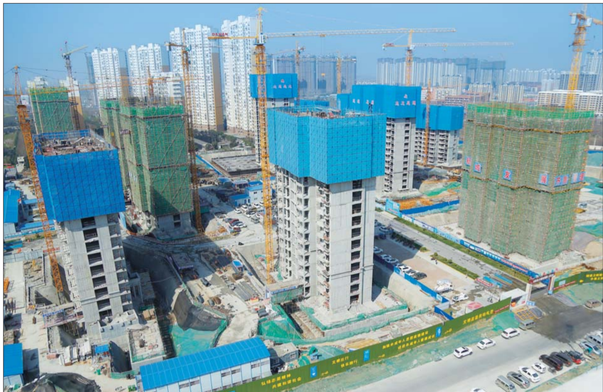
西北片区包括35栋主体建筑。
