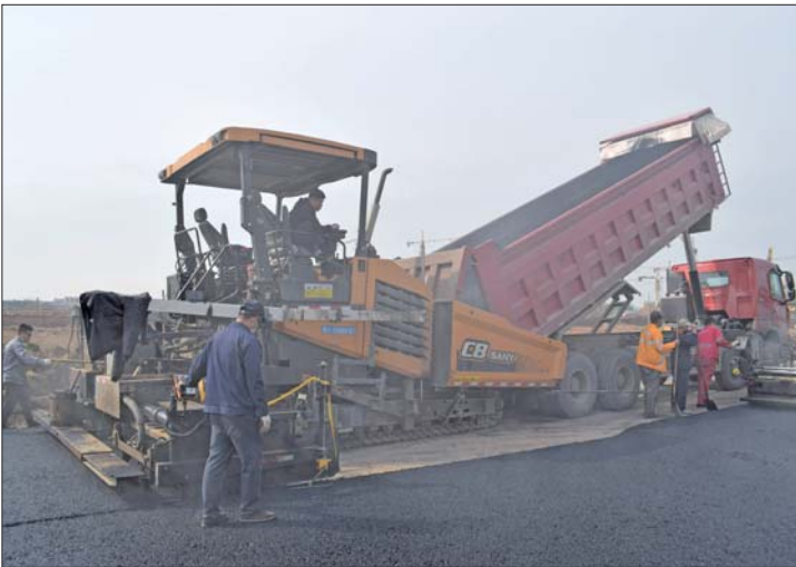
24日上午,济南新旧动能转换先行区国博城南侧的会展南路正式开铺沥青。 齐鲁晚报·齐鲁壹点记者 刘飞跃 摄
