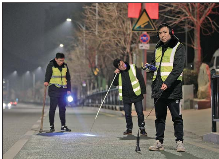
三人一个班组，用听漏仪划定漏点大致范围，听漏杆准确定位，边走边听，即使是在寒冷的冬天，一晚上也要走十几公里。
