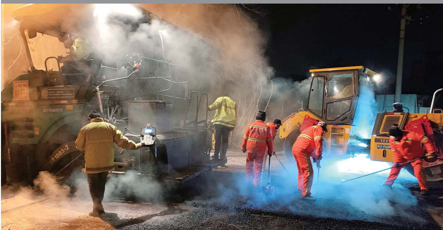
3月5日1:01, 济南千佛山东路, 工人正在铺路施工。
