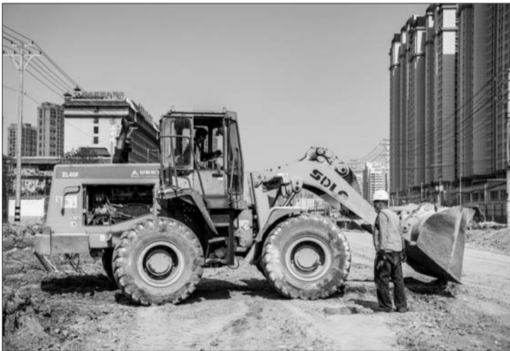
施工现场,工人加班加点抢工期。
