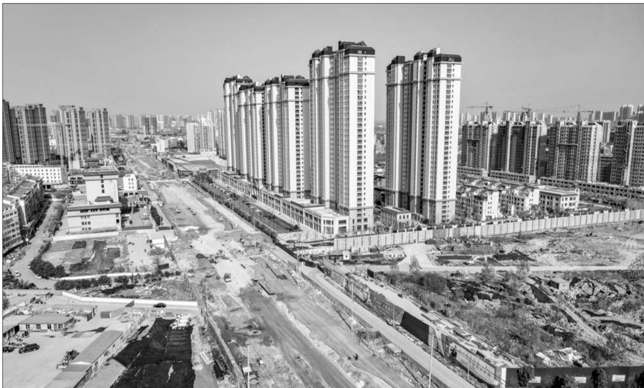
车站西路升级改造及综合管廊项目工地航拍。
