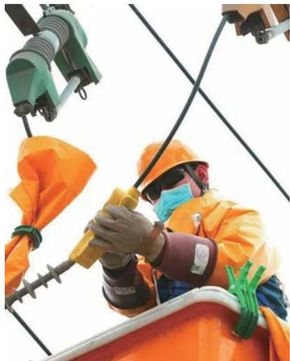
▲4月2日，国网淄博供电公司配电运检室工作人员为10千伏崔军1线宝生物支102HW-05-01号杆进行带电加装绝缘封装工作。(牛霖生)
