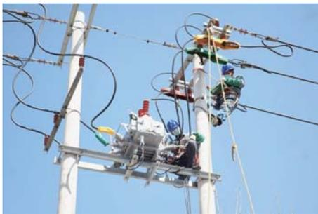
▲3月18日，国网桓台县供电公司工作人员在10千伏东营线10号杆安装柱上分段开关。(张洪青)
