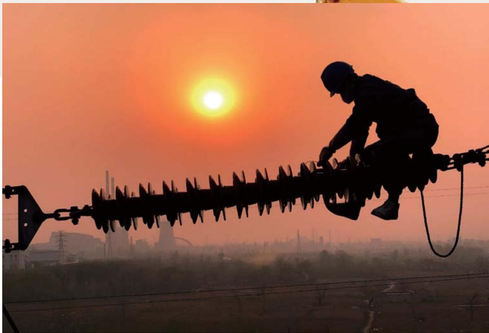
▲3月23日，国网淄博供电公司输电运检室工作人员对220千伏辛台 I、II 线3号塔瓷制绝缘子喷涂RTV涂料。(金增航)
