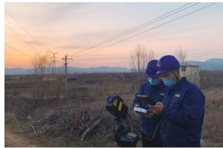
▲3月16日，国网淄博供电公司输电运检室工作人员使用远程激光异物清除设备清理220千伏源铁线44号塔挂线飘浮物。(孟浩)
