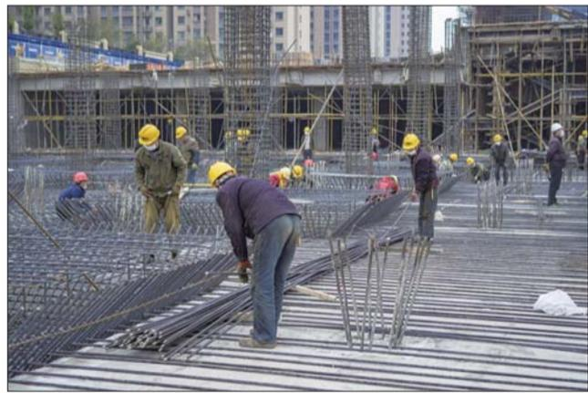
施工人员正进行钢筋绑扎作业。
