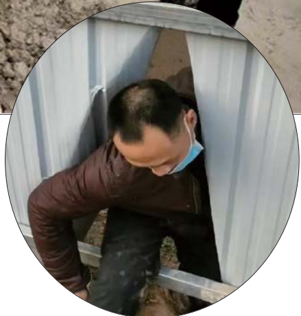
►事发工地围挡有缺口,成人也能钻进去。 受访对象供图
