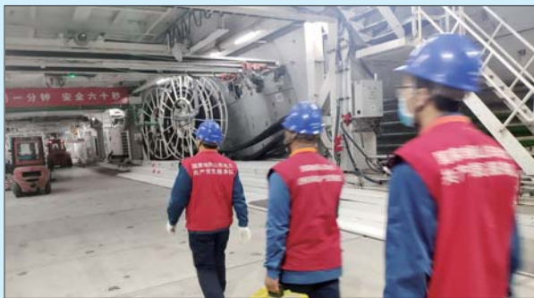
济南供电公司彩虹共产党员服务队来到济南穿黄隧道施工现场,开展安全用电检查。
