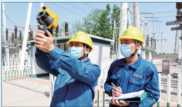
济南供电公司变电运维人员正在利用远红外测温仪对变电设备开展巡视检查。
