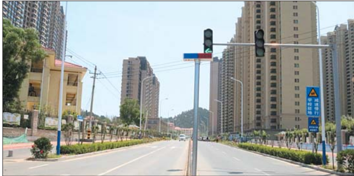
赶在学生开学前提前竣工的道路。
