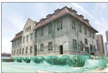
(小图)平移前,老楼被顶升1.65米高。齐鲁晚报·齐鲁壹点 记者 巩悦悦 摄
