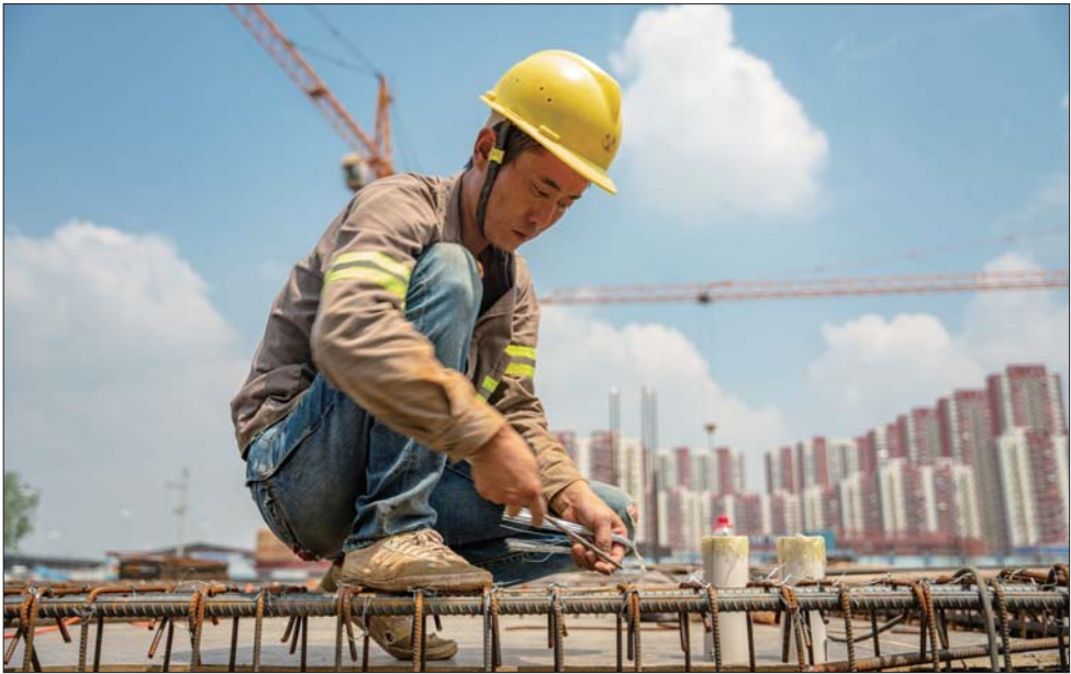
工人正在绑扎钢筋。
