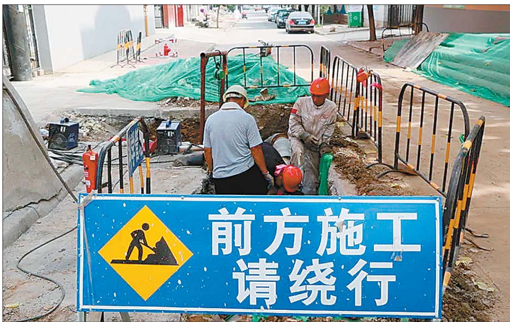
供热管网改造重点工程施工中。
