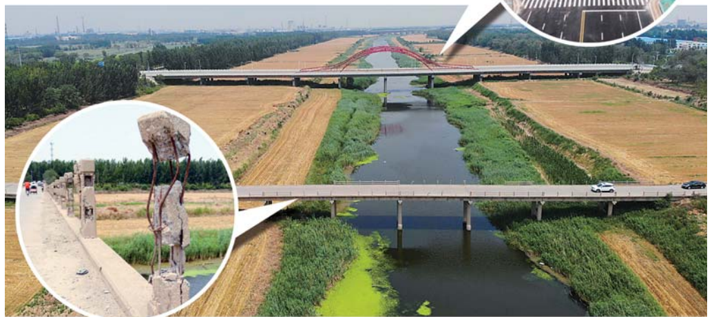
新桥和危桥相距数百米,上图:新桥路面硬化已全部完成,下图:危桥桥体和护栏钢筋外露。
