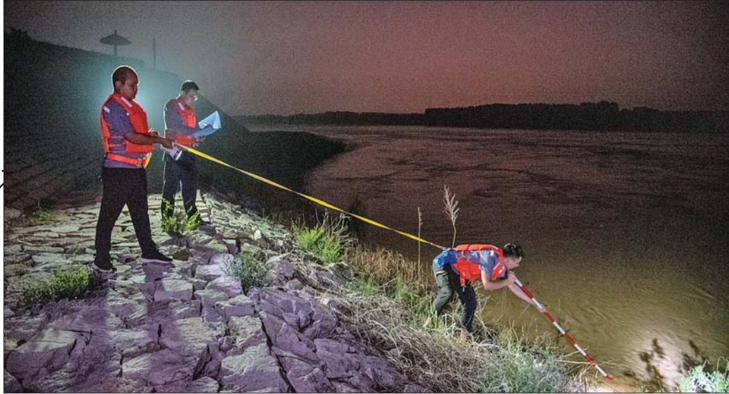
在队友配合下,张昊系着安全绳下到水边用探水杆检查水下的根石。 齐鲁晚报·齐鲁壹点记者 马志勇 摄
