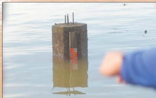
我国最大淡水湖鄱阳湖水位突破1998年历史极值,这是江西省鄱阳县鄱阳镇问桂道圩堤抢险施工现场(无人机照片,7月12日摄)。新华社发
