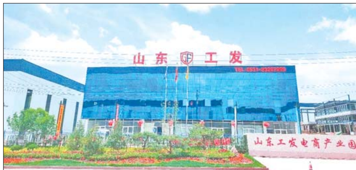
山东工发电子商务产业园项目,利用互联网和大数据云计算,整合机电、机床等传统产业,逐步形成了稳定的工业生态链。
