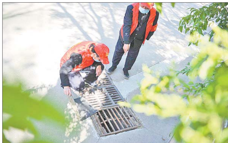
小区靠近兴济河，路面会有塌陷情况，老人们巡逻时就会留意路面和下水道的情况。
