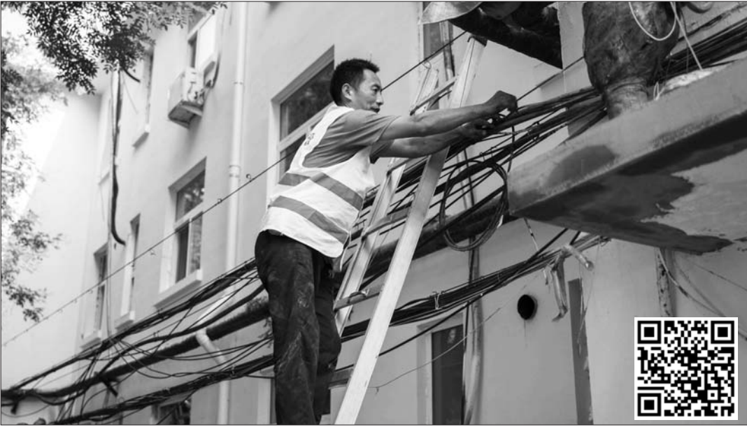
施工人员整理盘踞在钢丝绳上的弱电线路。
