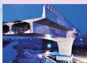
3月24日早晨6时30分,德滨高速公路跨京沪铁路高架桥工程南北两座连续梁经过40余分钟水平转体,分别精确进入预定位置,与已完工的德州北高架桥连续梁对接,标志着山东省最大、公路系统首次桥梁转体施工顺利完成。
