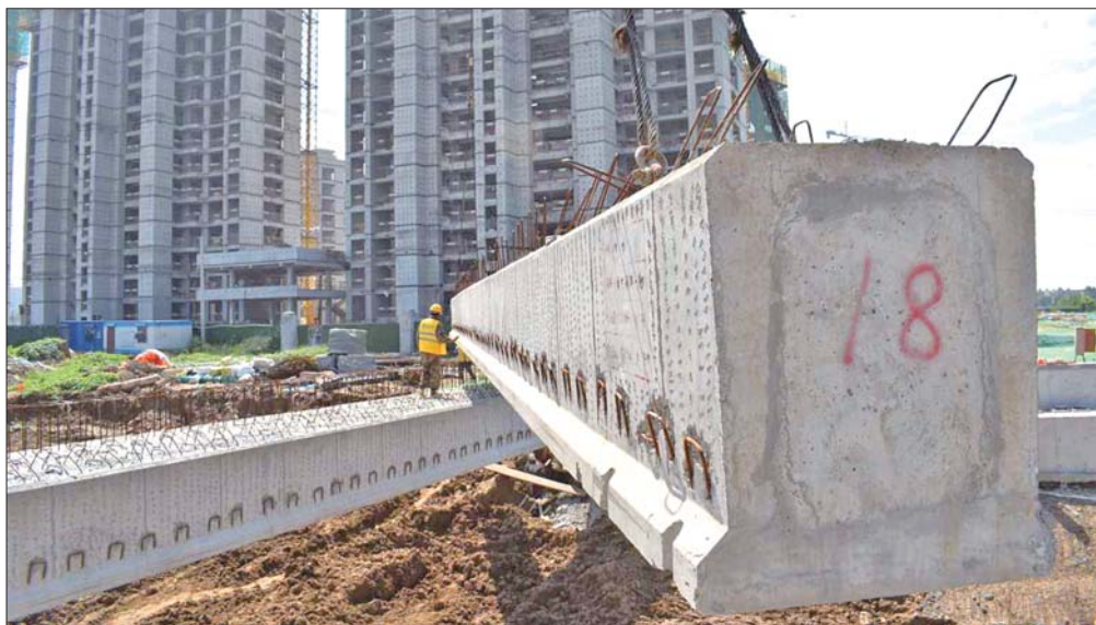
架设中的先行区国博城片区首座桥梁。 齐鲁晚报·齐鲁壹点记者 刘飞跃 摄
