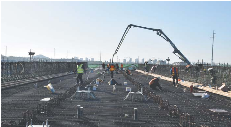
济南地铁2号线一期土建工程施工十标段箱梁混凝土浇筑。 通讯员 丁洁摄
