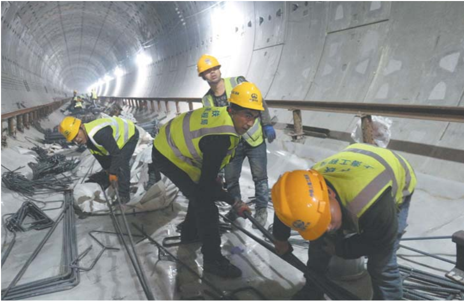
2020年3月18日，济南地铁2号线辛西区间左线钢弹簧浮置板钢筋绑扎在施工。
