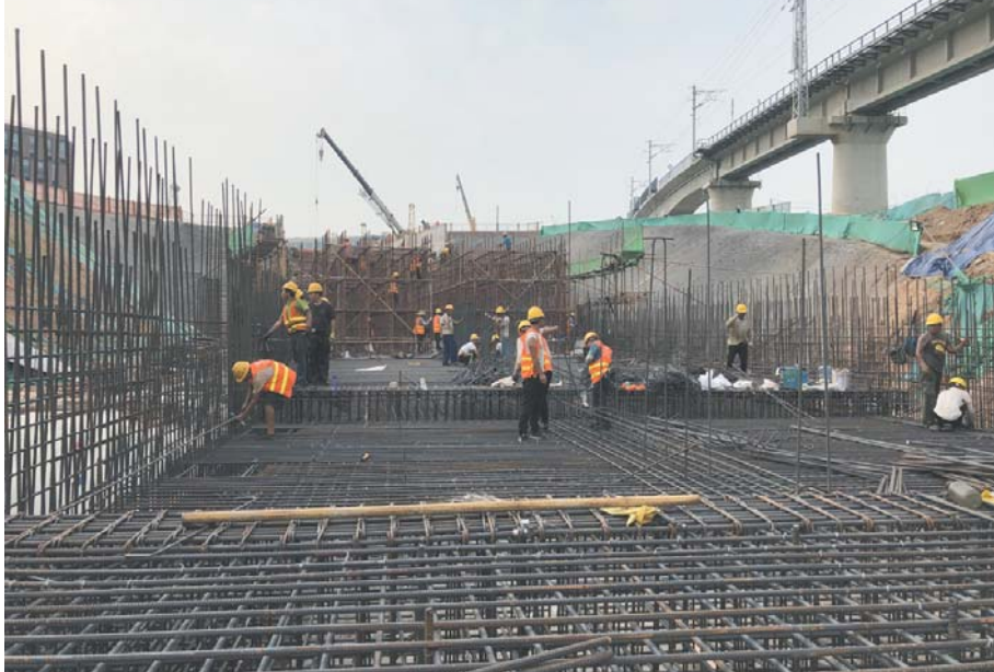
2019年5月份，济南地铁2号线主体结构施工工人正在做王府庄站出入段线主体结构钢筋的施工。
