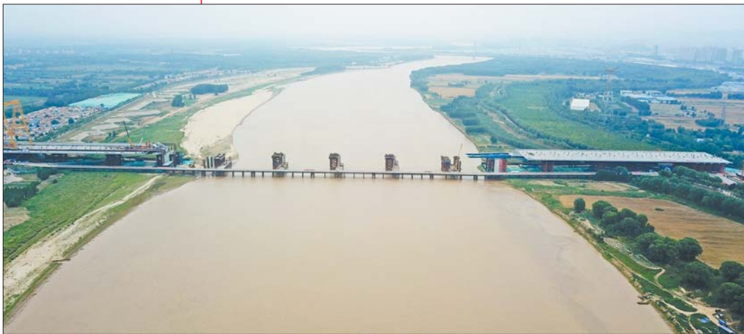
▲北跨打开城市发展框架,济南迎来巨大机遇。
