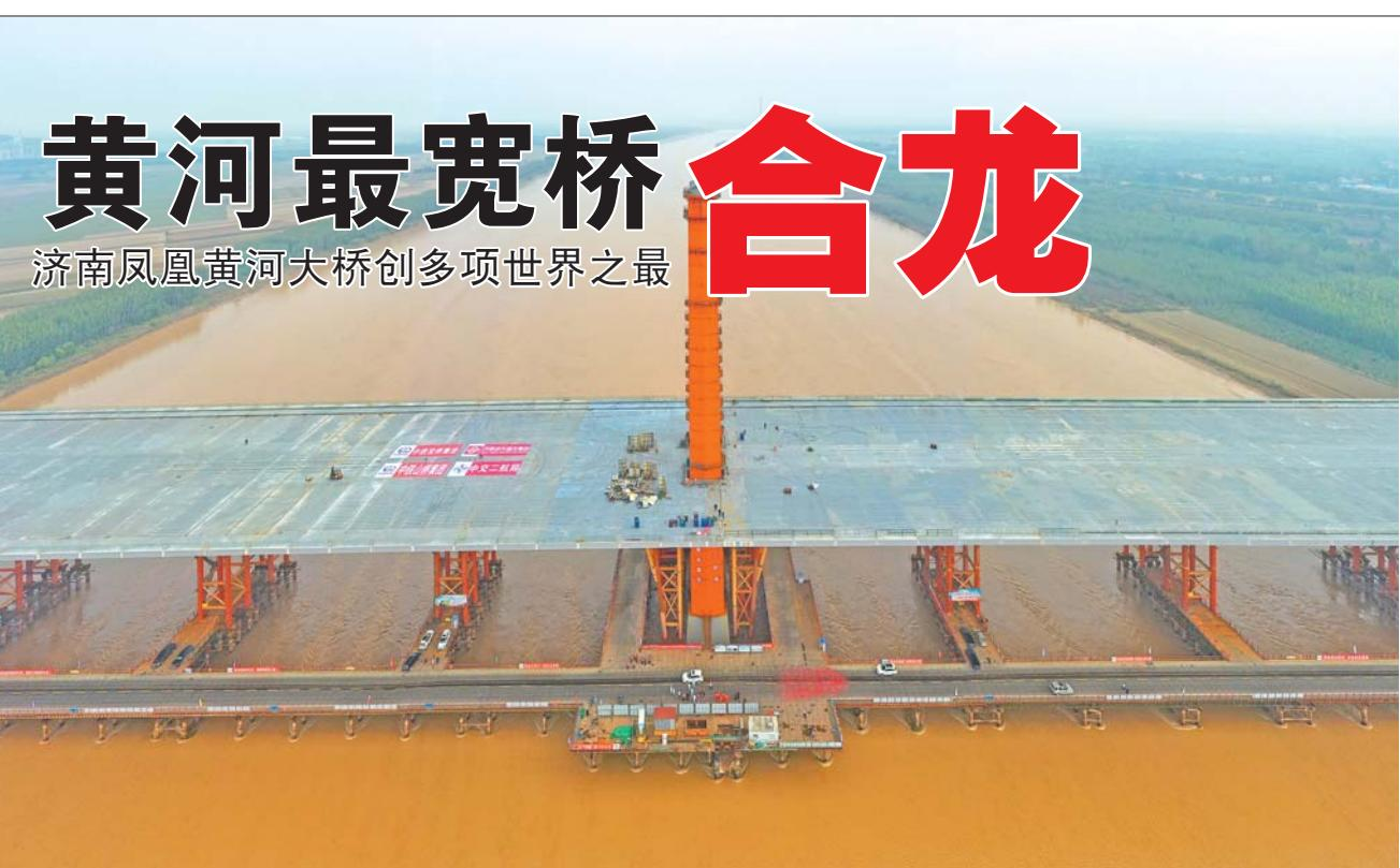
10月15日上午,正在施工的世界最大跨度三塔自锚式悬索桥——济南凤凰路黄河大桥主桥钢箱梁顶推顺利合龙。4.7万余吨钢箱梁从南北两岸朝黄河中间挪动600米后“牵手”。按照计划,济南凤凰黄河大桥将于明年底通车,届时过黄河用时不到4分钟。
