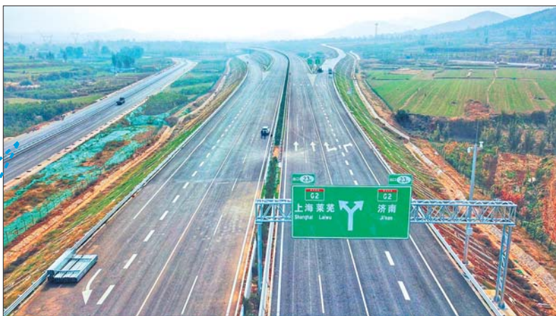
济南绕城高速大东环段二标段主线顺利贯通。
