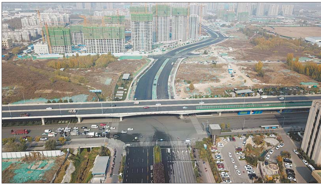
奥体中路北延段部分已经铺设沥青,周边是在建的大型楼盘。
