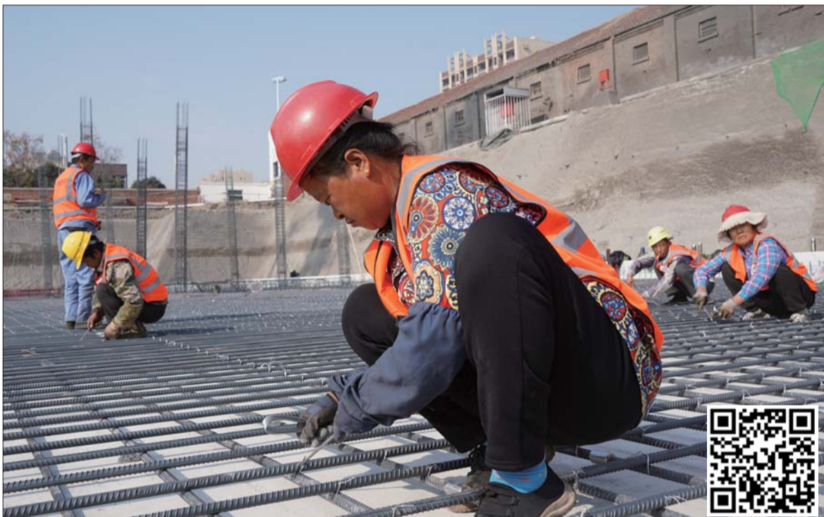
工人正在进行筏板筏板钢筋绑扎。
