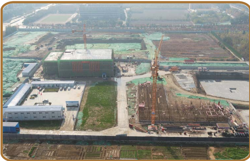
建设中的15共享社区(渔皇路)EPC项目。
