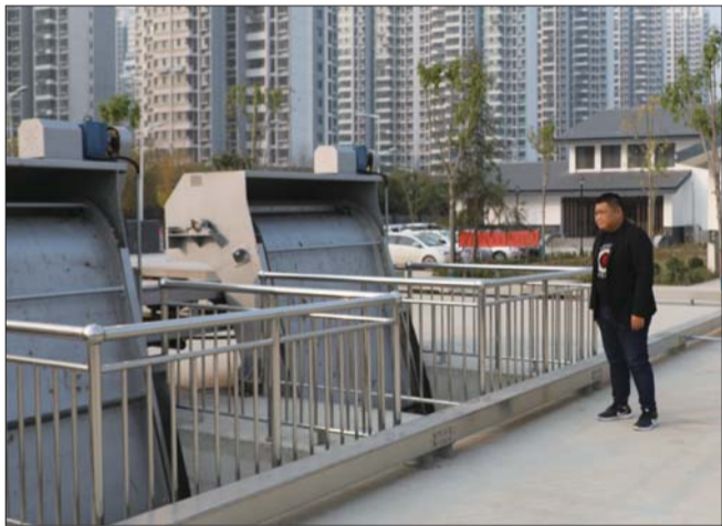
新运河泵站位于京杭路与青莲路路口北侧。
