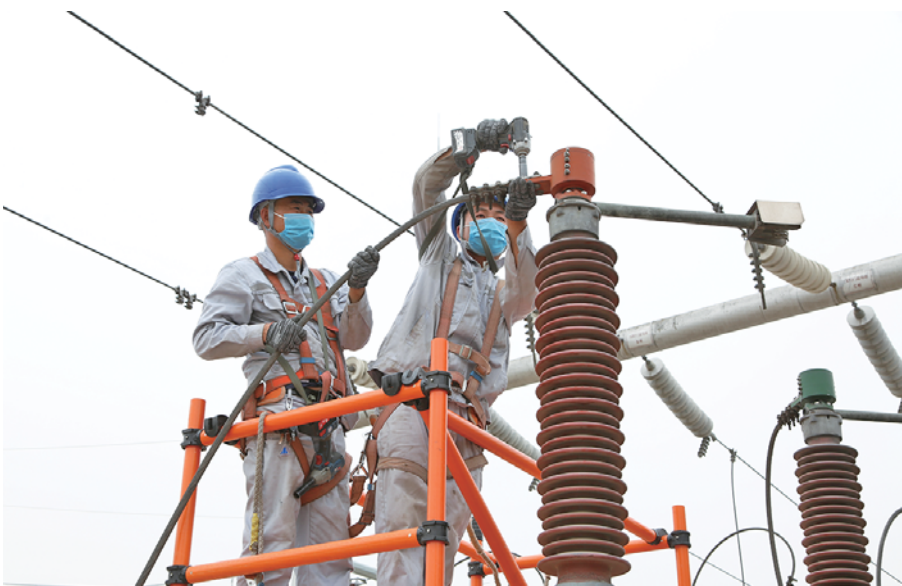
国网单县供电公司组织施工人员对110千伏李田楼变电站1号主变开展增容改造,确保客户可靠用电。
