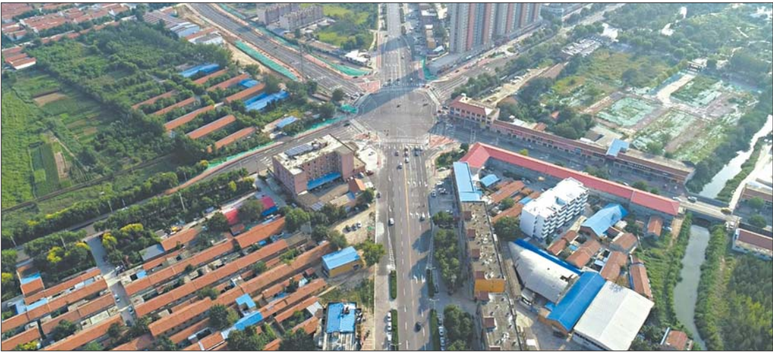
◀ 商河城区路网体系不断完善。
